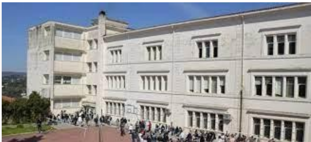
Sede via dei Lauri
