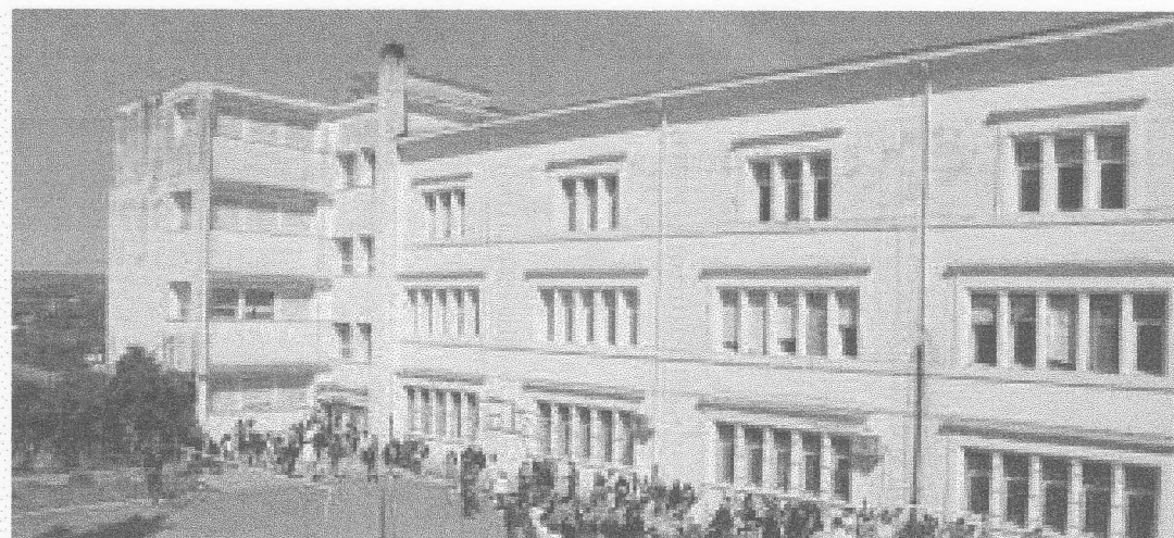
Sede via dei Lauri
