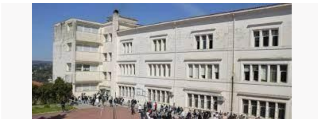
Sede via Dei Lauri
